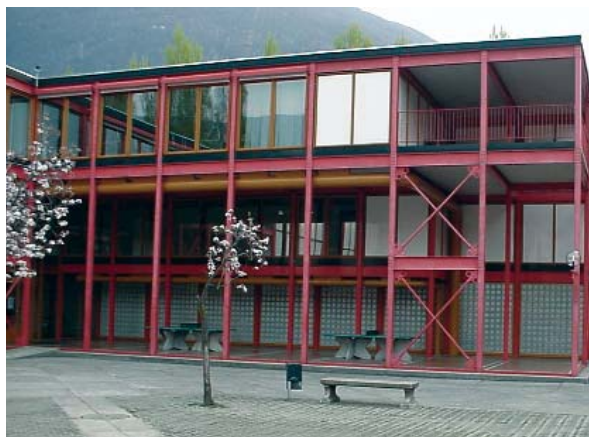
La scuola media di Losone, uno degli edifici scolastici oggetto dell’indagine.
