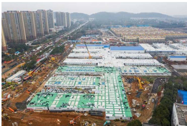
Luftaufnahme eines in 8 Tagen errichteten Krankenhauses zur Behandlung von Coronavirus-Patienten in Wuhan, Provinz Hubei, China (2. Februar 2020).
